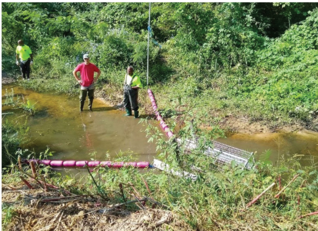
Pemasangan Litter Gitter, atau perangkap sampah, di sepanjang sungai kecil di AS.
